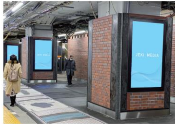
新橋駅南北通路
